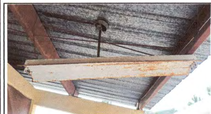
Foto 9: Sustitución de plafoneras y lámparas del sistema eléctrico.
