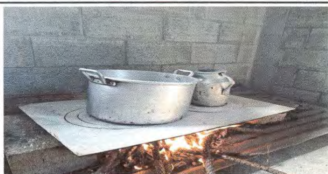
Foto 5: Sustitucion de estufa Rural (completa) incluye chimenea y plancha de metal
