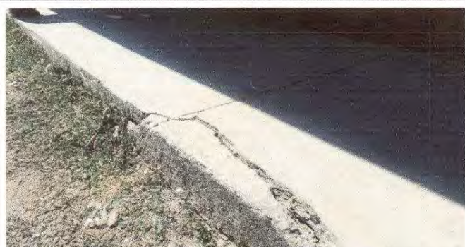
Foto 3: Reparacion de planchas de concreto de patio
