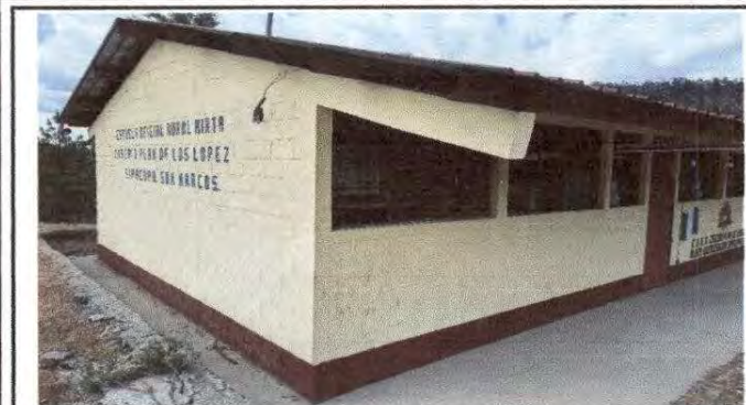
Foto 7: Sustitución de pintura interior y exterior.
