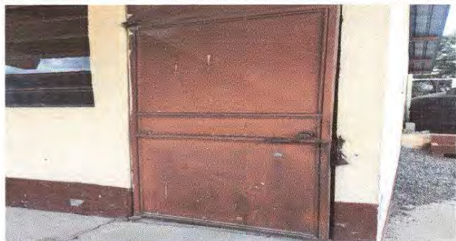
Foto1: Sustitucion de Puerta de metal
