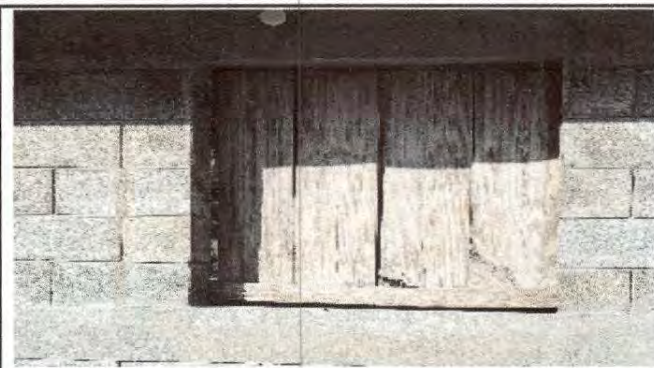
Foto 8: Sustitución de ventana de madera por ventana de metal.
